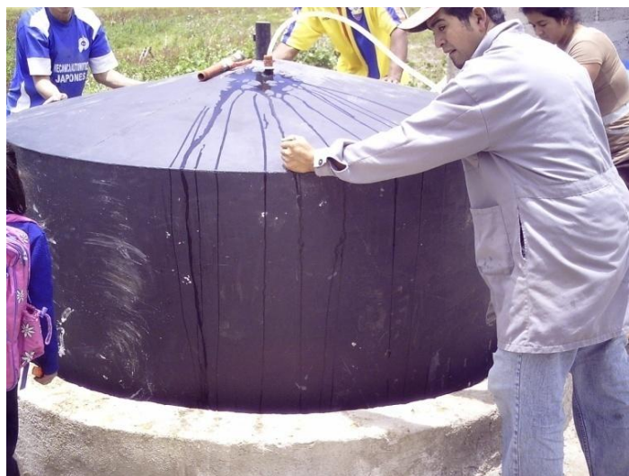
Fotografía 9.4 Colocación de la Campana
