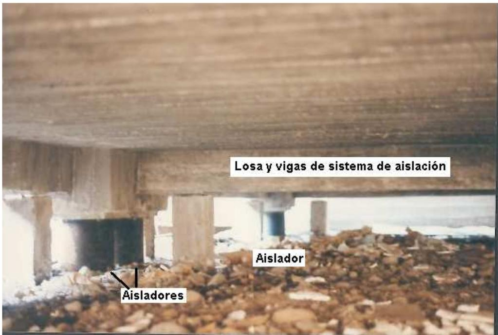
**Figura 2** Aisladores de base y losa de sistema de aislación.
