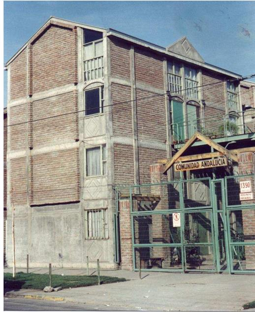
**Figura 4** Edificio Andalucía con aisladores de base elastoméricos.
