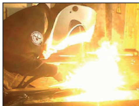
Figura 3.16: Remate de la estructura fija Fuente: José Hernández
