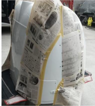
Luego se prepara la pintura con una relación de mezcla del 50/50 pintura y catalizador, y se la coloca en el recipiente de la pistola de pintura pasando primero por el filtro cónico para separar cualquier impureza, luego se conecta la línea de aire comprimido y se regula los flujos de aire y pintura, se comienza a pintar la franja a este proceso se le da unas 2 manos de pintura ya que como se tiene de base el blanco la pintura se adherirá con más sencillez
