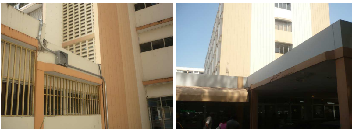
Figura 4. Muros de corte en gradas y fachada
