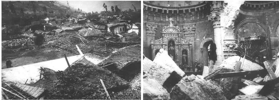
Figura 5 Daño registrados en el sismo de 1949.
