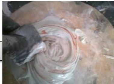
Preparación de masilla poliéster
