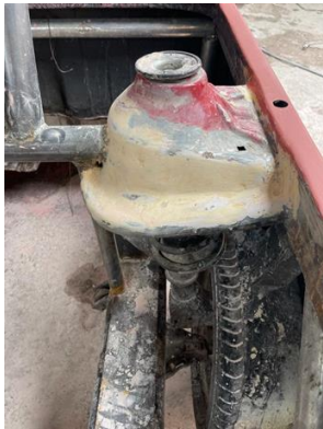
Masilla en área oxidada
