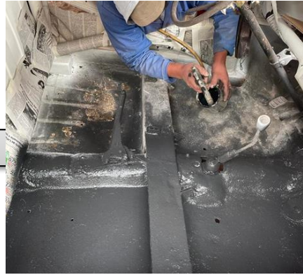
Aplicación de bate piedra
