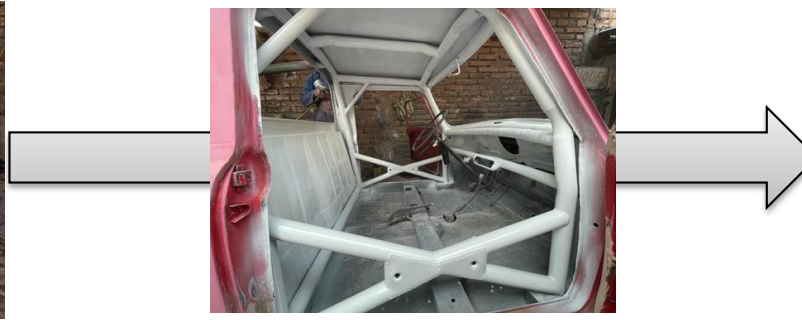
Aplicación de pintura en roll bar
