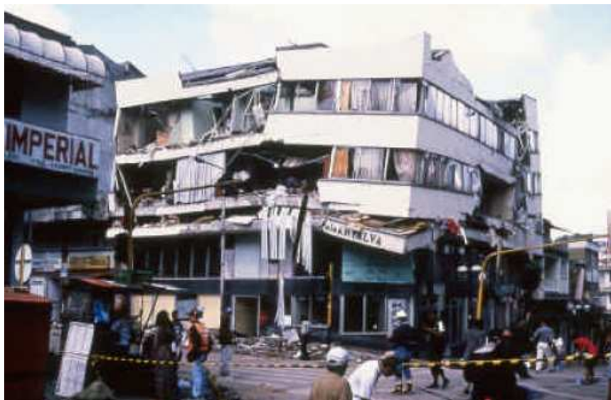
Figura 2 Edificio abierto que colapsó durante el sismo de 1999 en Colombia.
