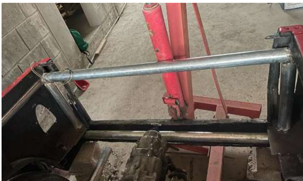
Figura 55. Armazón de la parte trasera armado
