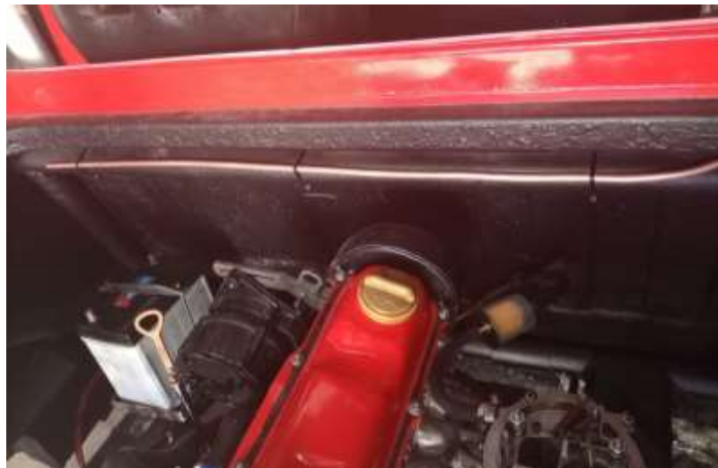
Figura 142. Instalación de cañerías de extintor al motor
