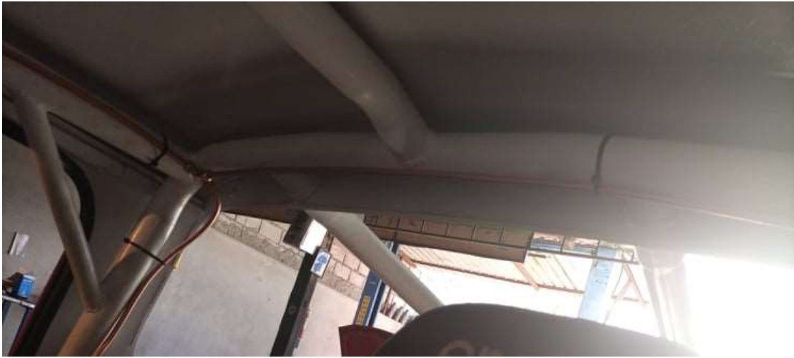
Figura 133. Instalación de cañerías
