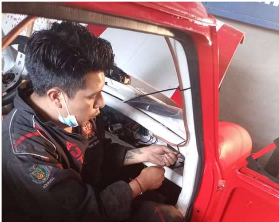
Figura 136. Instalación de cañerías en la cabina del vehículo
