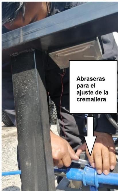
Como se puede apreciar en la figura 40 está la colocación de la cremallera. Para la instalación de la cremallera en su interior va con el apoyo hacia el chasis y cogida con dos abrazaderas y dos pernos y tuercas 13 para la sujetar el componente mecánico.
