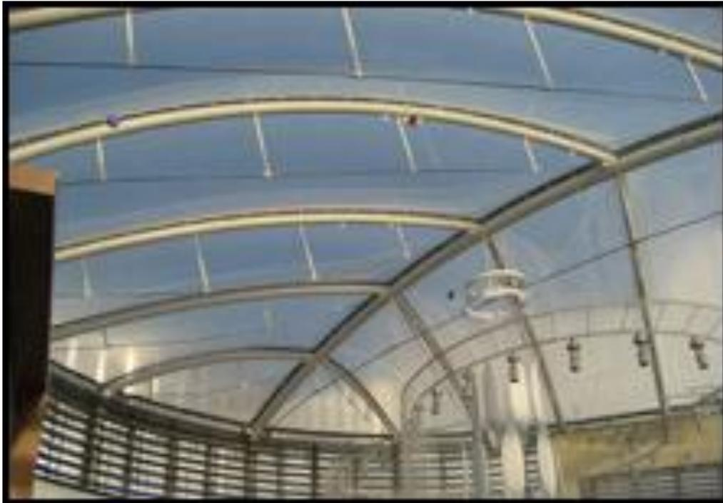
**Fig. 2.21** Cubierta de Policarbonato
