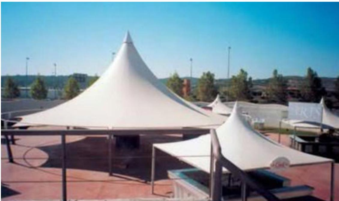
**Fig. 2.18** Estructura Soportada en Puntos
