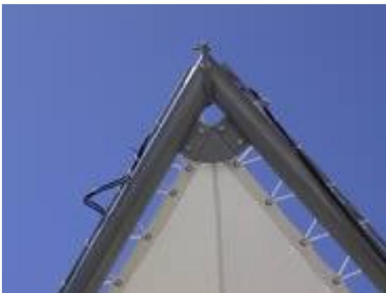
**Fig. 2.28** Borde Rígido en Punta
