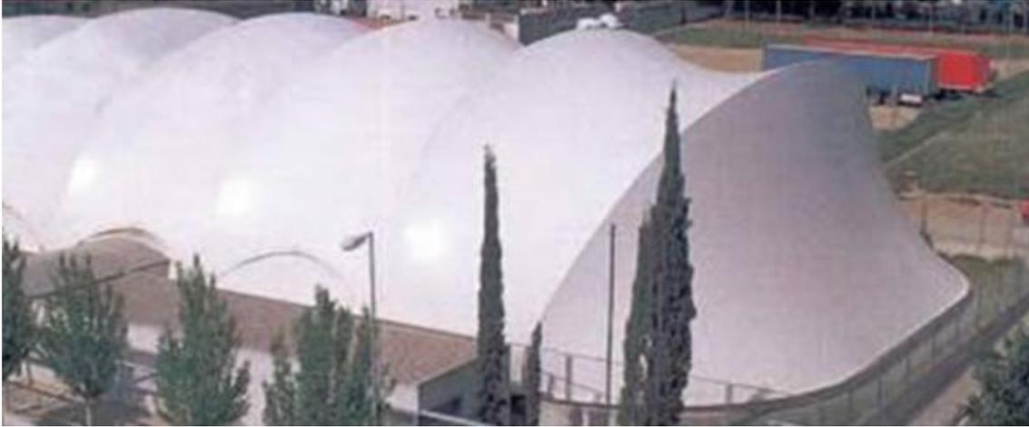
**Fig. 2.17** Estructura Soportada por Arcos Transversales
