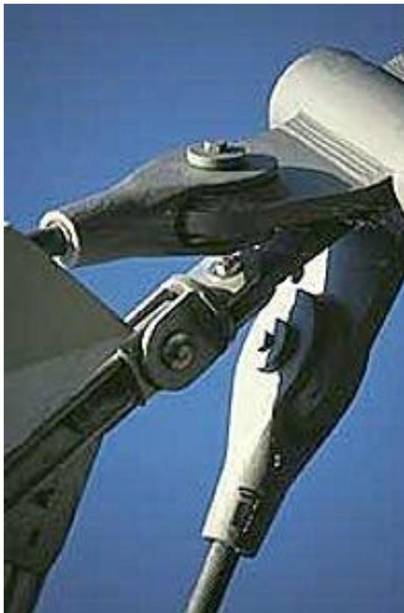
**Fig. 3.19** Anclaje de acero con columna
