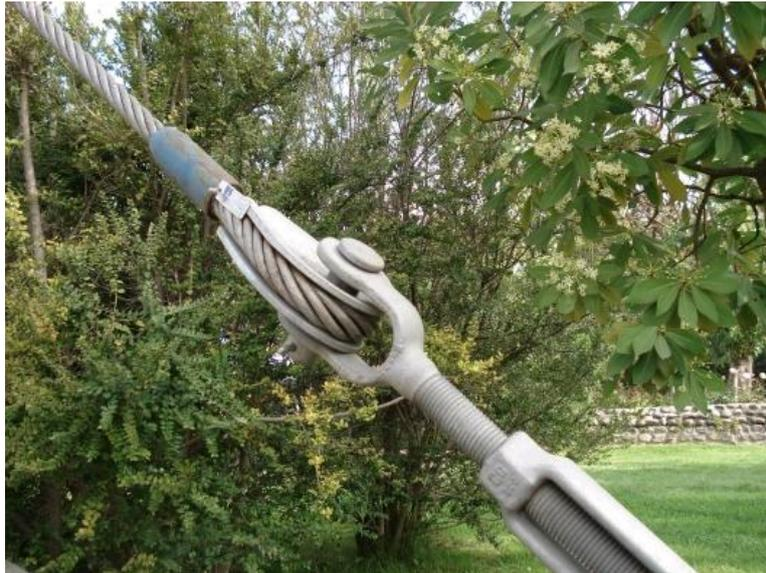
**Fig. 3.18** Anclaje de acero para estructuras tensadas
