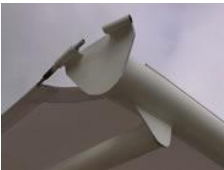
**Fig. 2.29** Borde Rígido Desplazado
