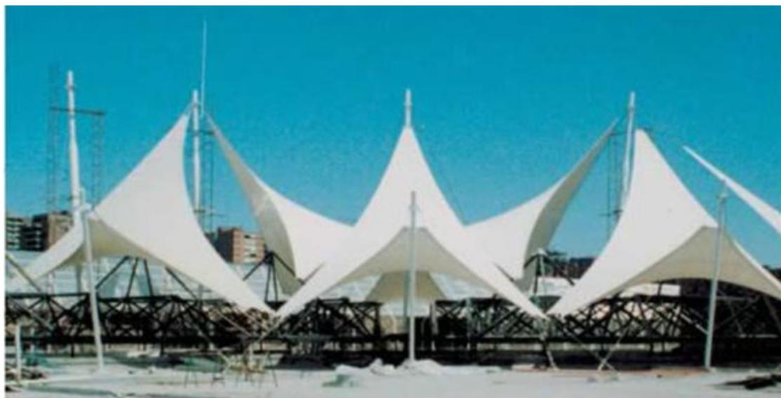
Fig. 2.13 Superficies de Doble Curvatura Negativa
