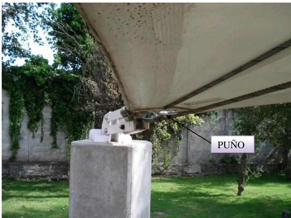
**Fig. 3.16** Puño de acero (rígido) y anclaje (móvil) empotrado.
