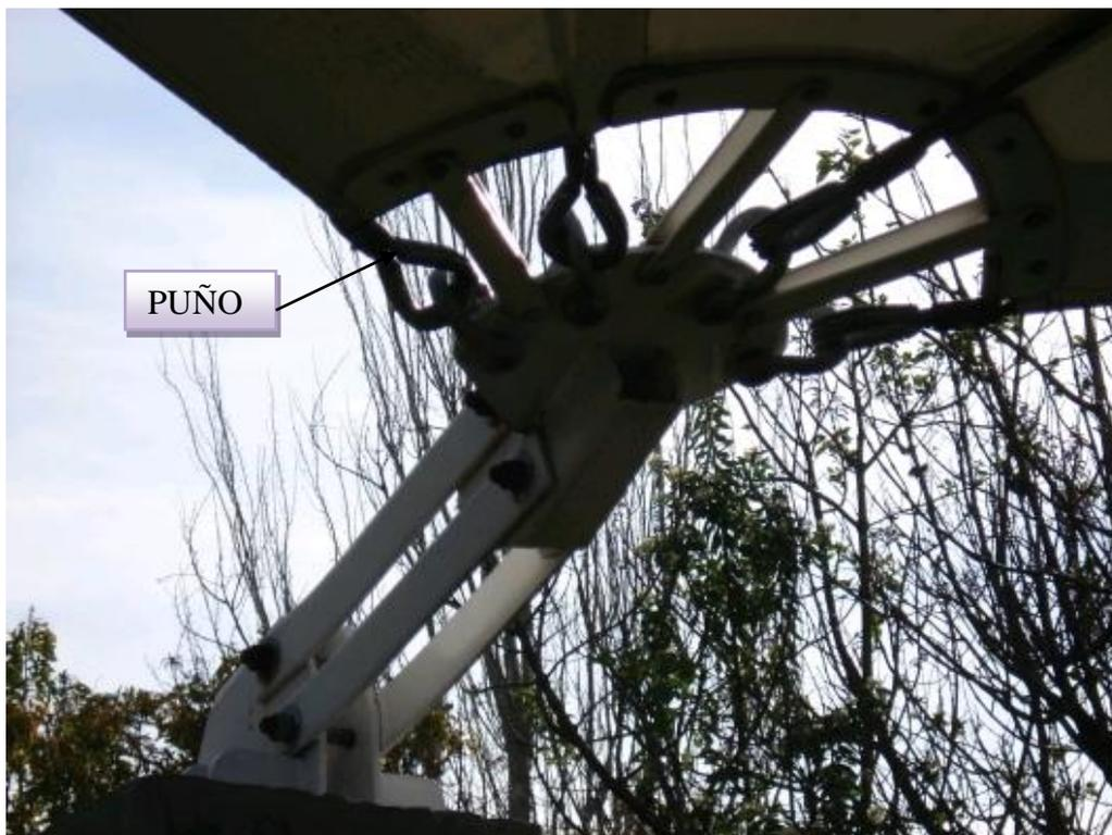
**Fig. 3.15** Puño de acero (rígido) y anclaje (móvil)
