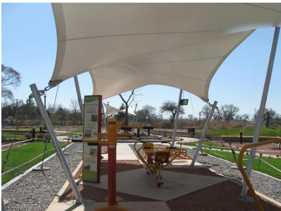
**Fig. 2.27** Estructura con Bordes Flexibles
