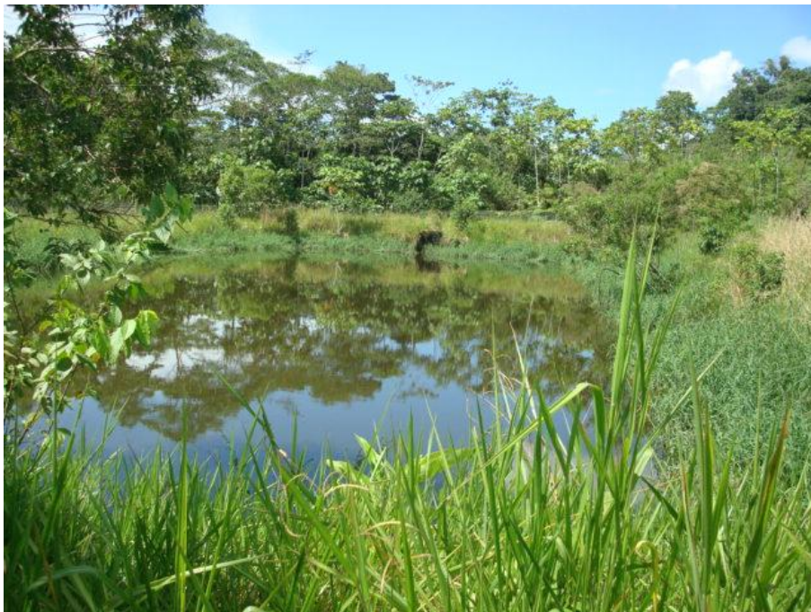
Planta de Tratamiento Aguas Residuales Lagunas de San Vicente
