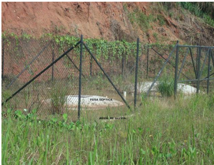
Figura 3.11.: Planta de Tratamiento del Barrio La Pampa en invierno
