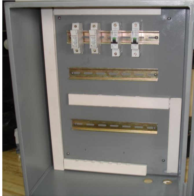
Figura 5.9 Vista interior de los dispositivos de protección
