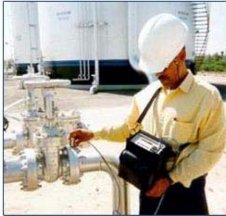
Fig. 2.24. Inspección por emisiones acústicas
