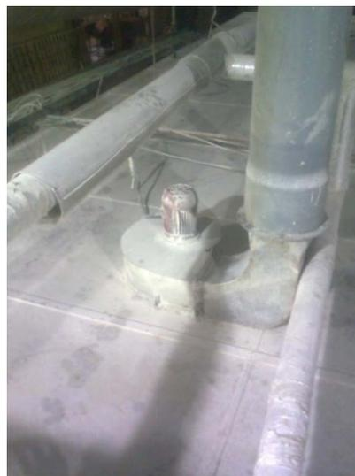
Figura 2.2: Capsula de Extracción del Secador
