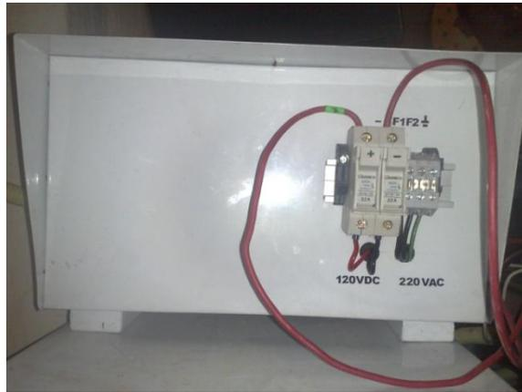
**Figura. 3.2** Inversor de Corriente 120 VDC – 220 VAC
