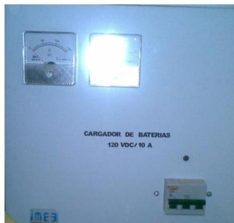
**Figura. 3.5** Cargador de Baterías
