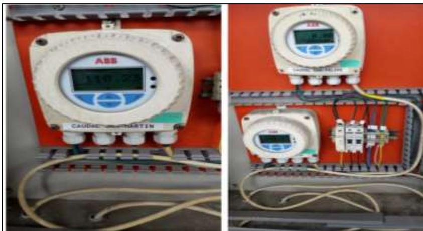
**Condiciones de puesta en marcha.** – En el manual del fabricante ABB exponen que, para su funcionamiento, se considera un test automático del correcto funcionamiento el equipo con el objeto de verificar los datos almacenados en la memoria del transmisor con respecto a los datos en la memoria del sensor” (ABB Instrumentation, 2021).
