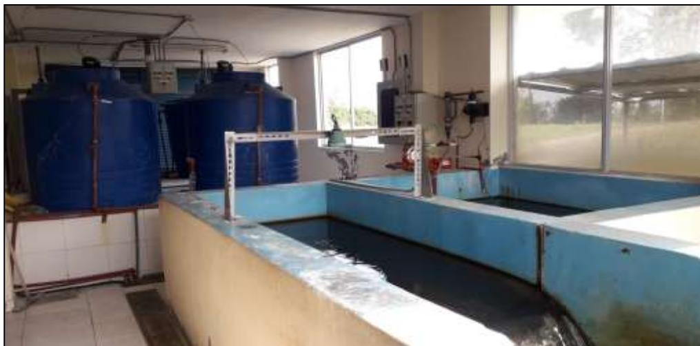
Este equipo en tiempos actuales no estaba operativo debido al desconocimiento de configuración gracias a la intervención se lo pudo poner en funcionamiento y con activación de alarmas cuando existe un exceso de agua cruda, con el objeto de que los operarios puedan actuar y cerrar las compuertas en caso de que exista un exceso de agua; a continuación, se muestran los parámetros de conexión y configuración para su correcto funcionamiento.
