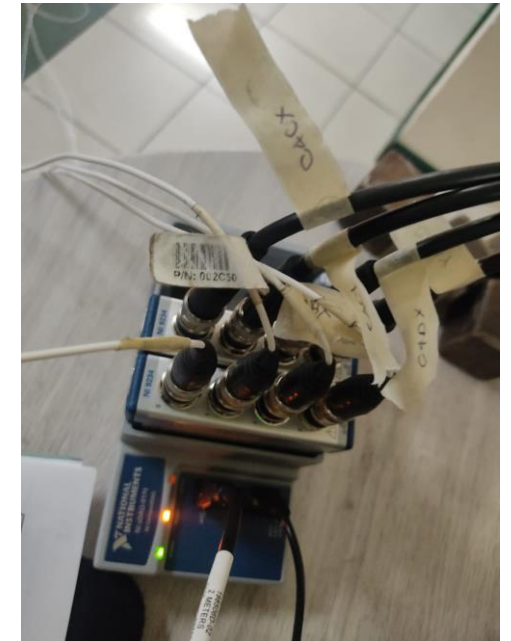
Conexión de los sensores al DAQ.
