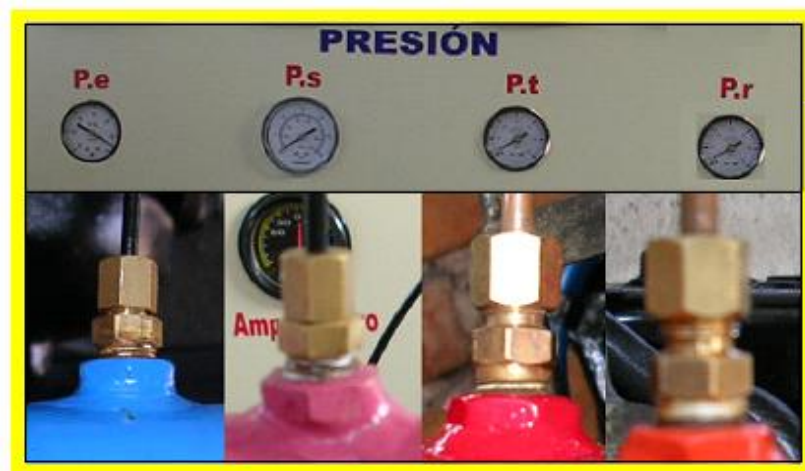
Figura 4.11. Prueba de los manómetros de presión
