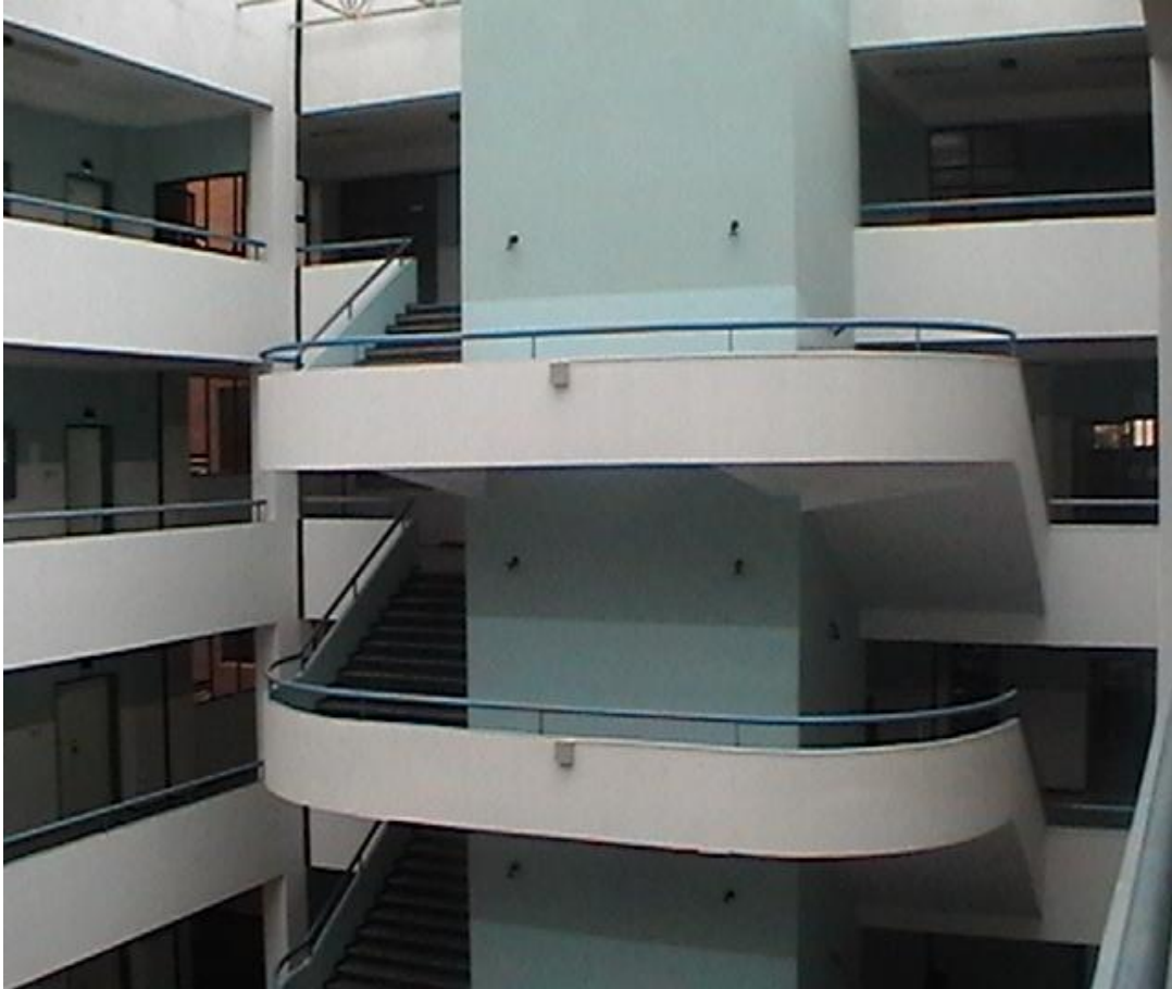
Figura 5.13 conexión de la red inalámbrica a la red del edificio para acceder al Internet
