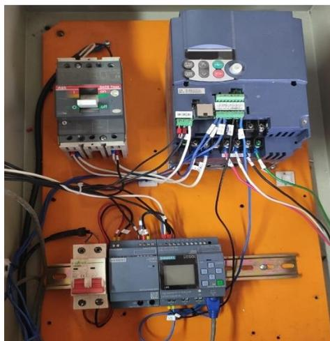
*Nota.* Tablero de control compuesto por un variador de frecuencia y Logo 8 RCE con sus protecciones
