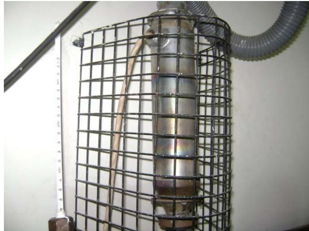
**Figura 2.12 Resistencia eléctrica**
