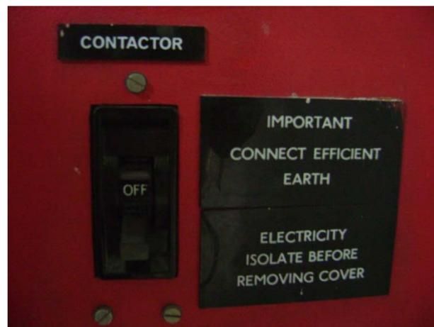
**Figura 2.7 Interruptor de encendido del panel de control**
