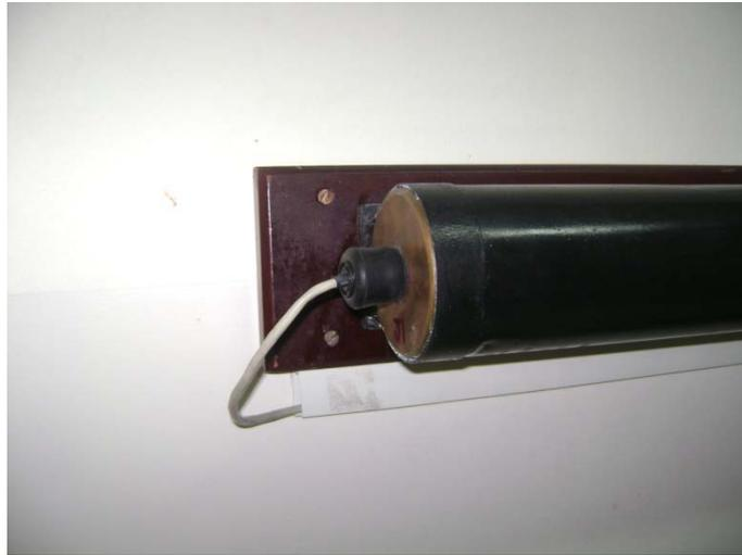
**Figura 6.8 Sensores de temperatura a la entrada y salida del aire**
