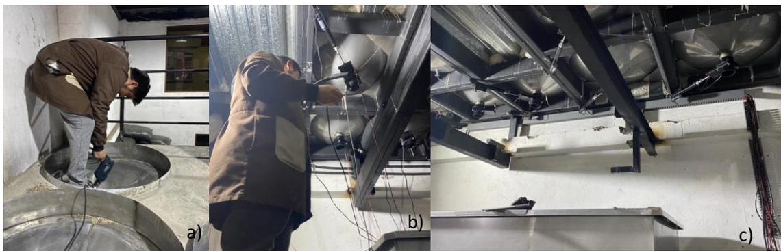
*Nota.* El literal a y b muestran la colocación de los sensores capacitivos y actuadores respectivamente, en el literal c se muestra el cableado colocado a través de canaletas ranuradas.
