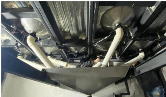
Con los sensores capacitivos colocados se procedió a cortar las bases los tanques de polietileno para colocarlos en los embudos, figura 66.
