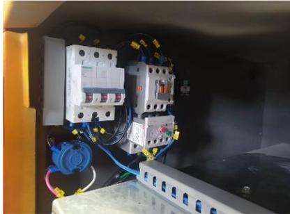
Diseño del diagrama eléctrico e implementación de cables N°18 con el uso de terminales para mejorar la adherencia a los dispositivos eléctricos
