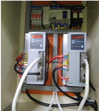
Se realizó una reconfiguración del circuito eléctrico, y etiquetado de las líneas para detectar fácilmente la correspondencia de los cables con los equipos electrónicos
