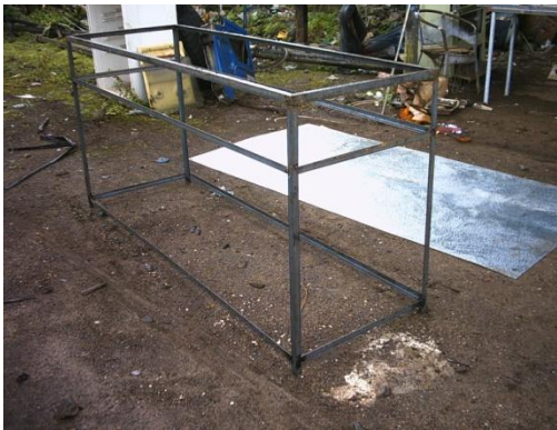
Figura Nº 2.3 Armado de la estructura del mesón.
