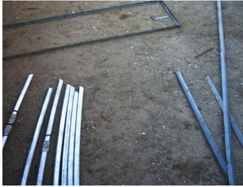
Figura Nº 2.2 Corte del material para el armado del mesón.
