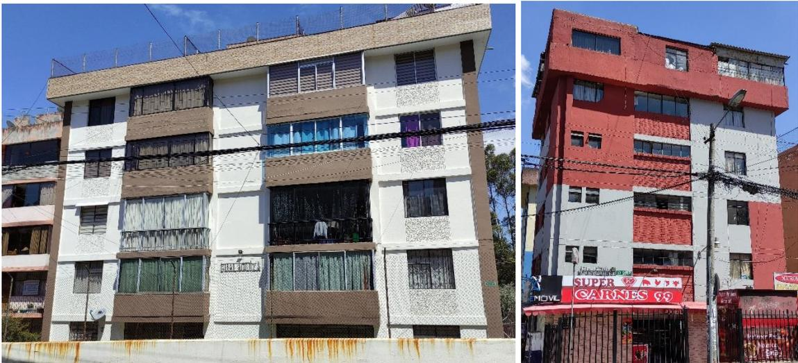
En la **Figura 11** se puede observar algunas de las variaciones de los modelos matemáticos que fueron realizadas; se colocó una distribución irregular de la mampostería con el fin de capturar los efectos de torsión en planta. Esta distribución obedece a parámetros aleatorios de colocación de los paneles de relleno, por lo que, luego de un proceso de filtrado se escogió las curvas que se apeguen a una realidad y presenten un comportamiento sin decaimientos de capacidad bruscos.
