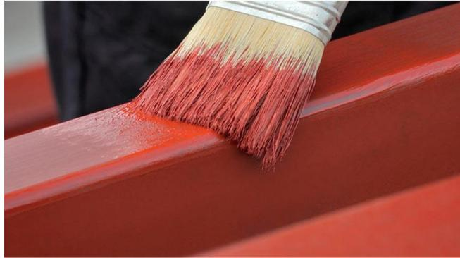
*Nota.* En la figura 9 tenemos el tipo de pintura anticorrosiva que es una base o primera capa de imprimación de pintura que se ha de dar a una superficie.
