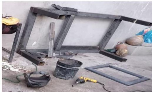
*Nota.* En la figura 23 se hizo de cortar el tubo en las medidas que se necesitaba para la creación del bastidor.
