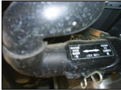
Figura 1.45. Ubicación de la válvula aire caliente.
