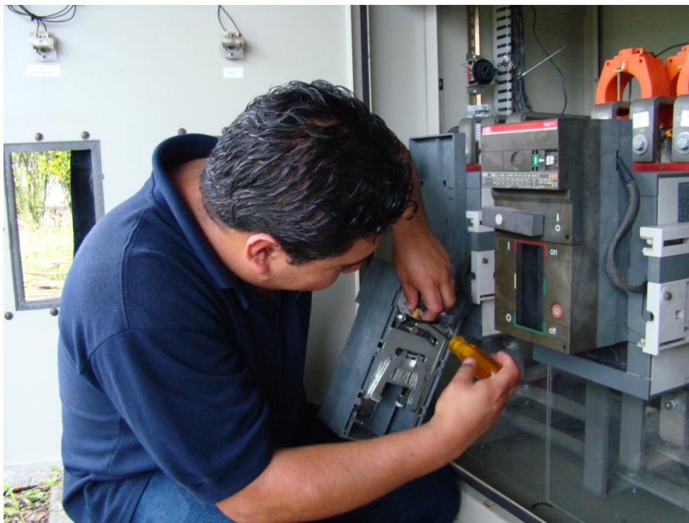
Fotografía 3.- Colocación de elementos
