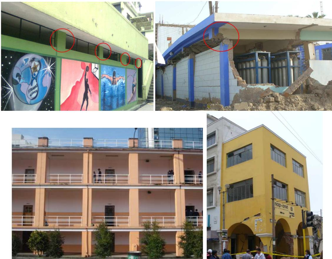
**Figura 1** Estructuras vulnerables de Quito a la izquierda y fallas registradas en el sismo de Perú de 2007.
