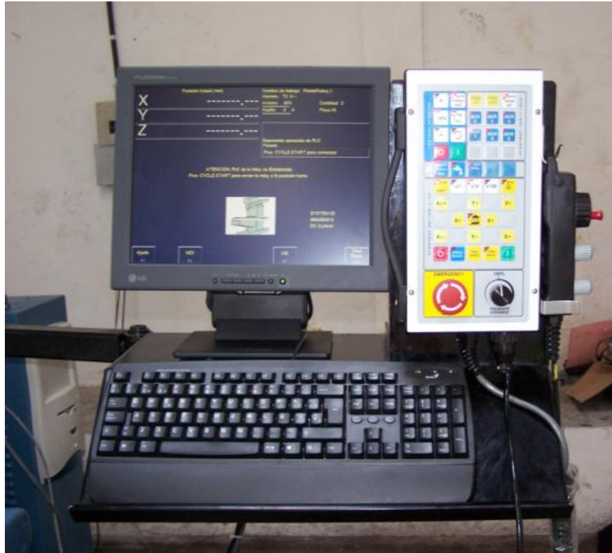
Sistema de Control de Operación
