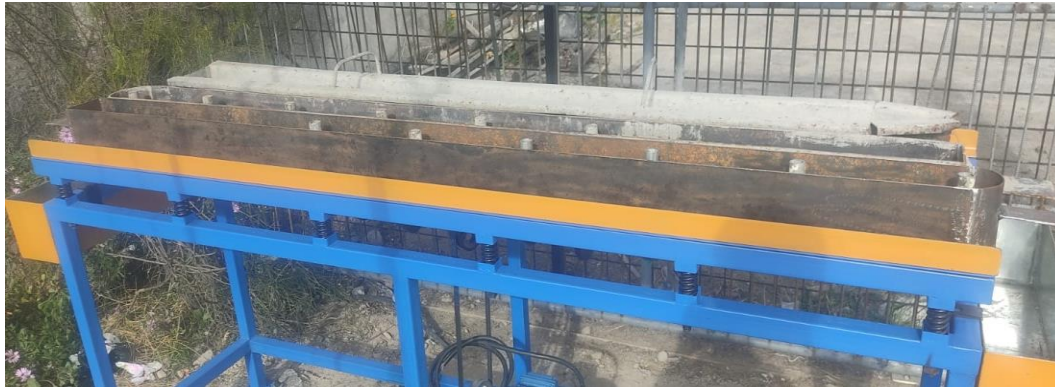
Puesta de moldes y pruebas de funcionamiento
