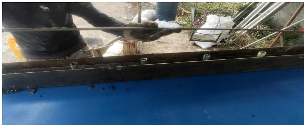
*Nota.* Se muestra la inserción de la estructura de acero en el molde de forma física.
