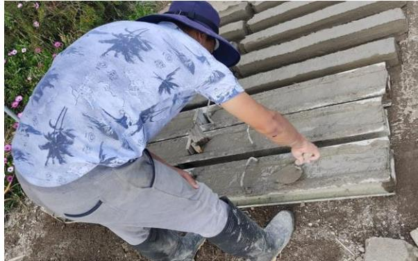
*Nota.* Se muestra el método de compactación manual de los prefabricados de hormigón.
