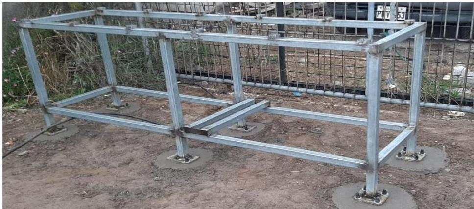
*Nota.* Se muestra el empotramiento de la máquina con sus respectivas bases.
