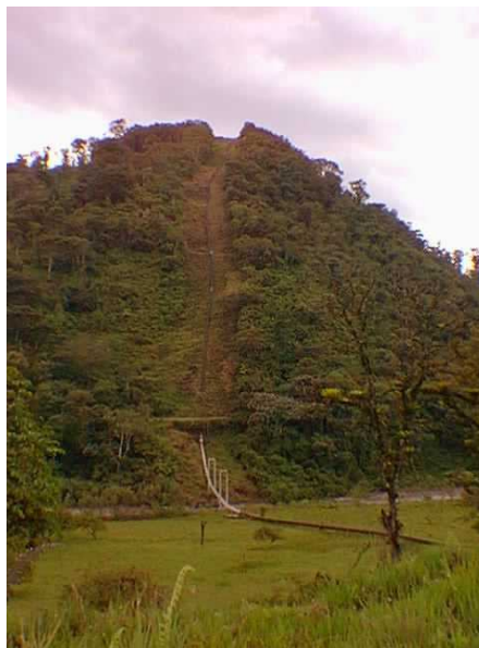
Fig. 1.20 Tubería del SOTE (Forma de mantenimiento)
