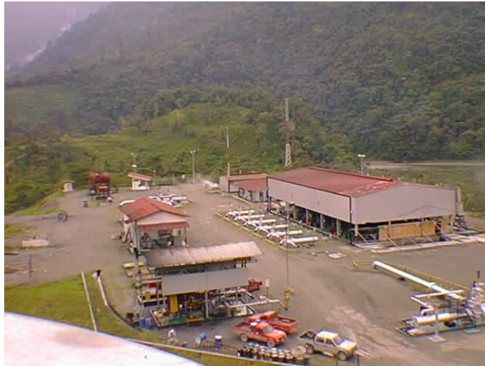
Fig. 1.7 Estación de rebombeo "El Salado"
