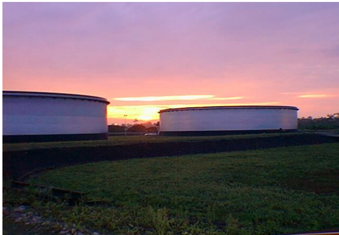
Fig. 1.2 Tanques de recepción en Lago Agrio
