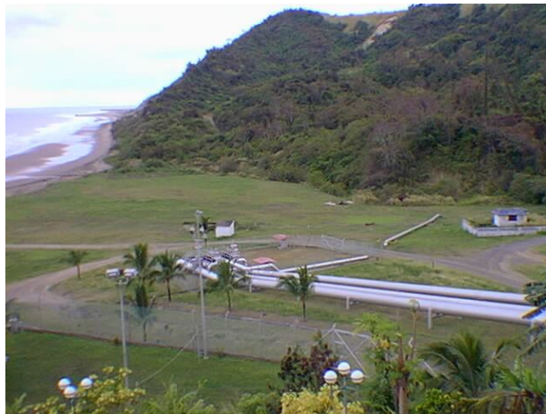
Fig. 1.17 Líneas de cargas y válvulas de control de flujo
