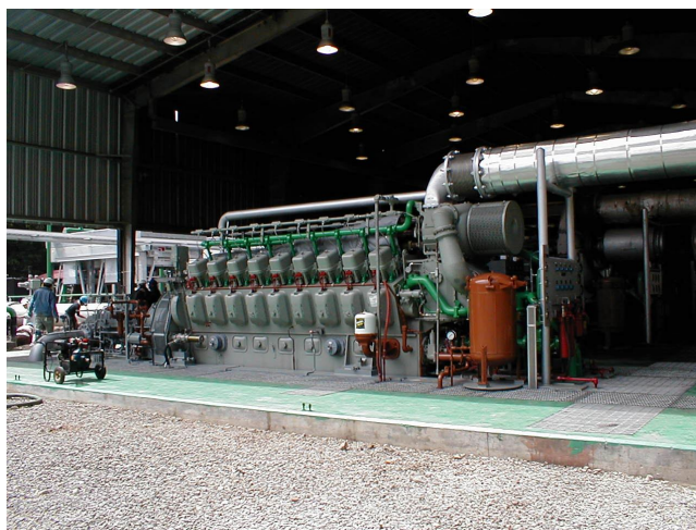
Fig. 1.4 Unidad de Bombeo
