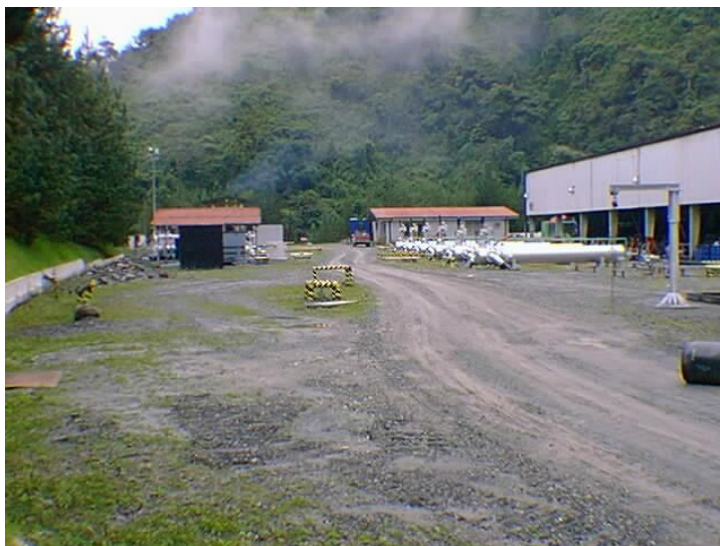
Fig. 1.8 Estación de rebombeo "Baeza"
