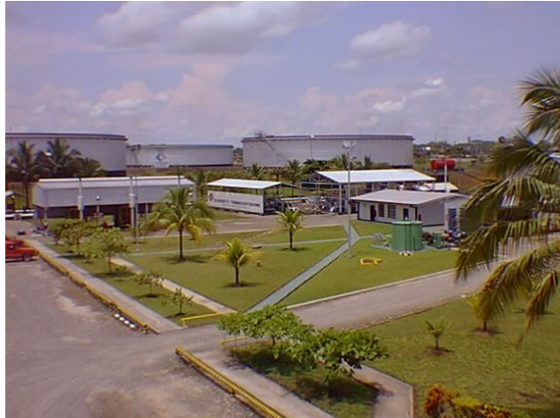
Fig. 1.5 Estación de bombeo "Lago Agrio"
