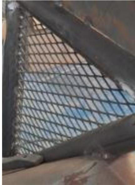
*Nota.* Se aplica la soldadura por técnica de punteado para unir la plancha expandida a los tubos de la estructura.
