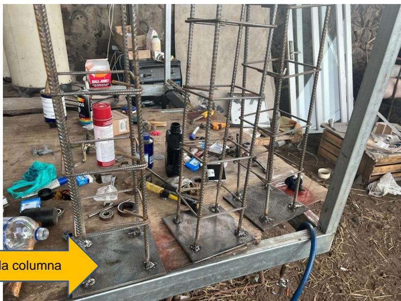
Una vez soldadas las placas, se procedió a fundir las columnas que soportan toda la estructura como lo muestra la Figura 29.
