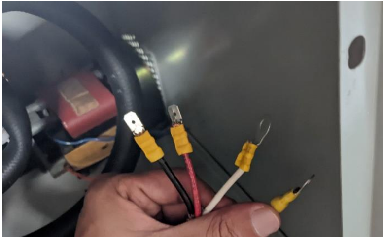
Colocación de terminales en cables de alimentación y en cables de puesta a tierra
