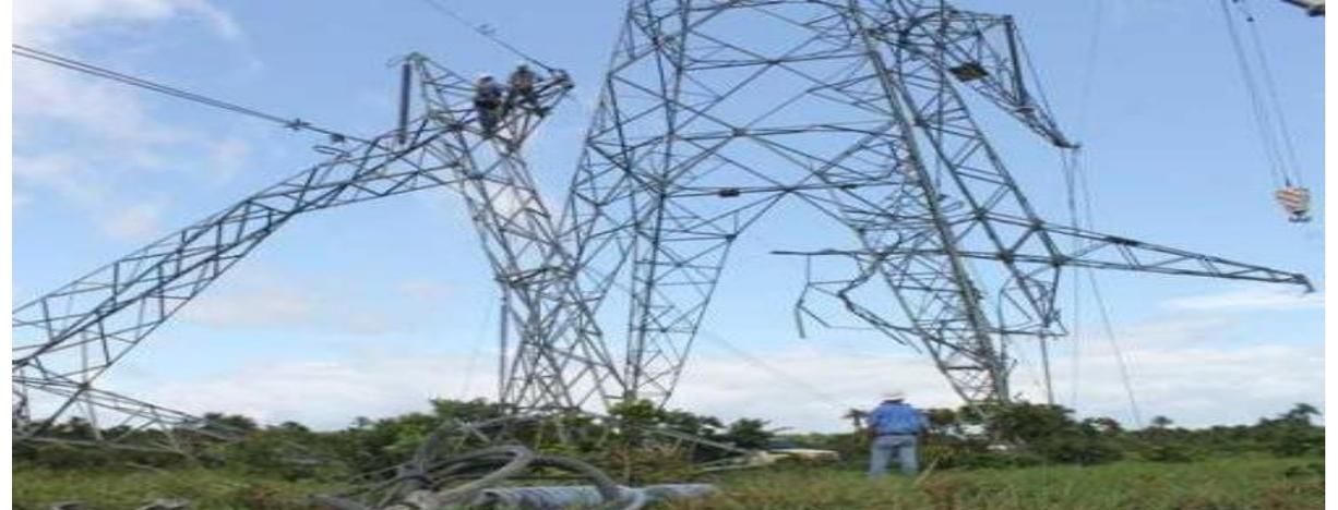
*Ilustración 1: Torres eléctricas de alta tensión después de un terremoto.*
