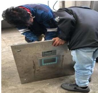
*Nota.* Colocación de la pantalla táctil en el tablero de control en la zona de ozonificación.
