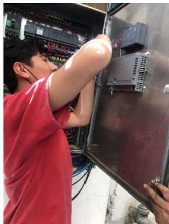
*Nota.* Instalación de la pantalla KTP en el tablero de la zona de ozonificación.
