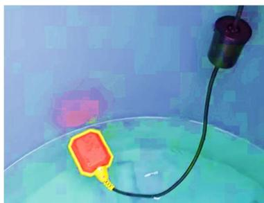
*Nota.* Interruptor de nivel para el accionamiento e interrupción de la bomba en nivel bajo y nivel alto de agua.
