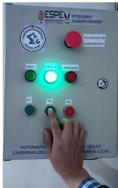
3. El tablero de control también cuenta con un pulsador (P0), que permite detener el sistema en cualquier momento y cuenta con una luz indicadora de color rojo que me indica cuando el sistema se apaga, como se observa en la Figura 116.
