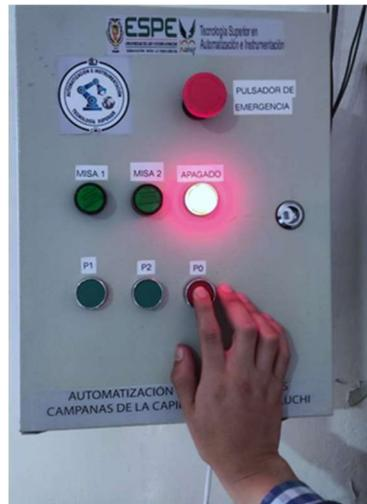
4. Para precautelar la seguridad, el tablero de control cuenta con un pulsador de emergencia que, al ser accionado el sistema se desactivará y no se podrá activar ningún tono de Misa 1 o Misa 2, como se indica en la Figura 117.
