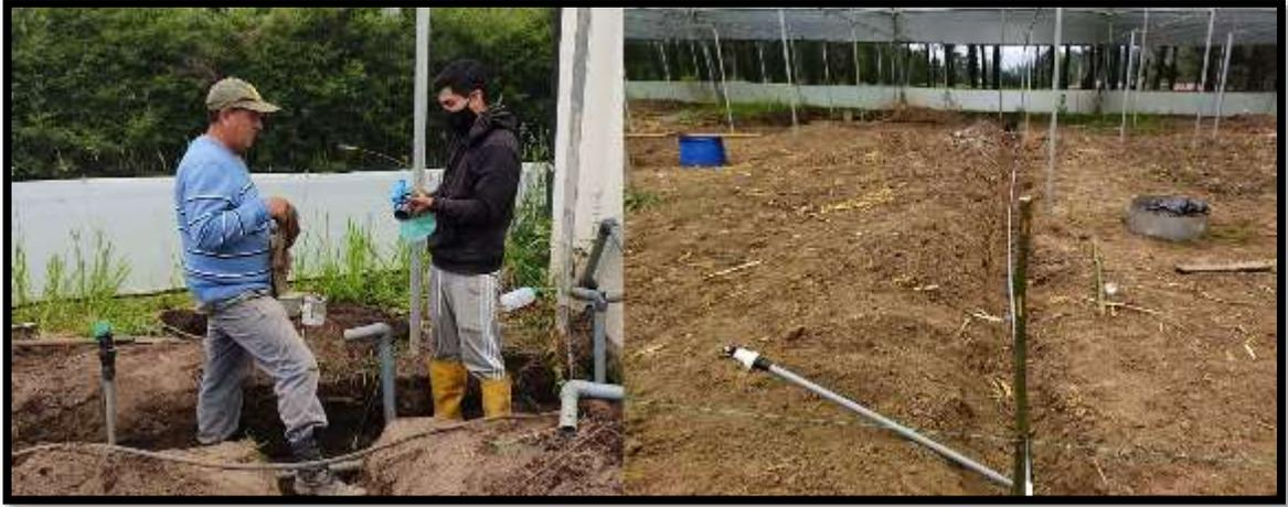
*Nota.* Instalación de tubería principal, laterales, válvulas y aspersores.
