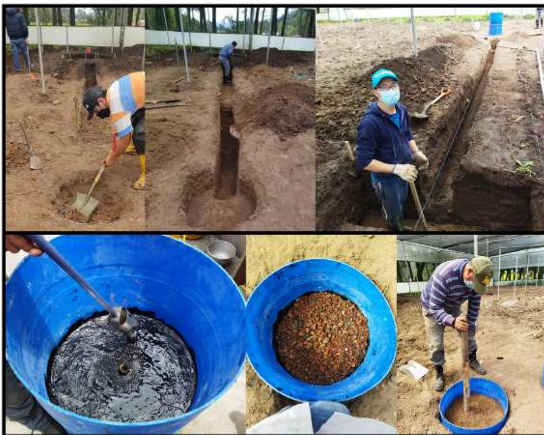
*Nota.* Primero se ubicó el centro del invernadero y luego se midió el nivel de compactación en el sitio donde se colocaría el tanque, posteriormente se retiró el suelo y se instaló, procurando mantener el mismo nivel de compactación con el que fue sacado el suelo al interior del tanque.
