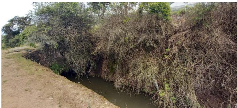
*Nota.* La figura muestra la presencia de vegetación que puede llegar a contaminar u obstaculizar el flujo de agua del canal.
