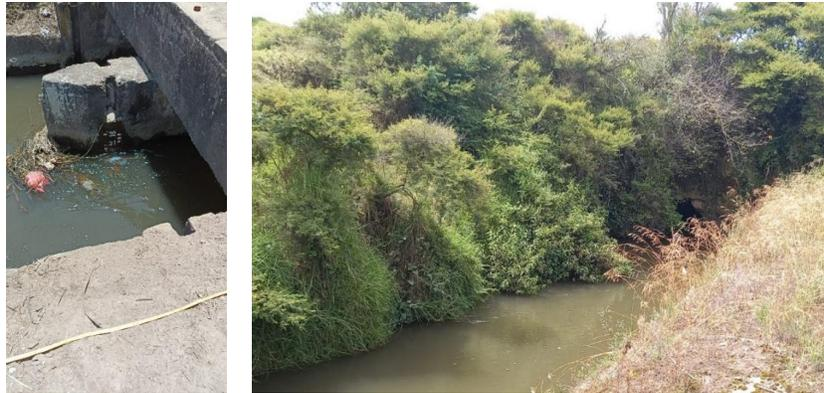
*Nota.* La figura muestra la presencia de basura y vegetación dentro del canal de riego.
