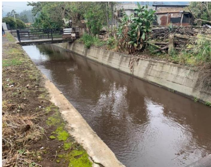
*Nota.* La figura muestra la sección transversal del canal, en donde se realizó la aplicación del Método del Flotador.
