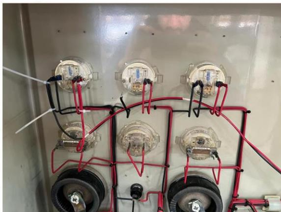
El nuevo cableado instalado en el equipo para su repotenciación fue realizado bajo las especificaciones del fabricante el mismo que mencionaba que los cables a utilizarse debe ser de  $1.5 \text{ mm}^2$ . La siguiente figura muestra el nuevo cableado que sirve tanto para la parte eléctrica como electrónica del equipo.
