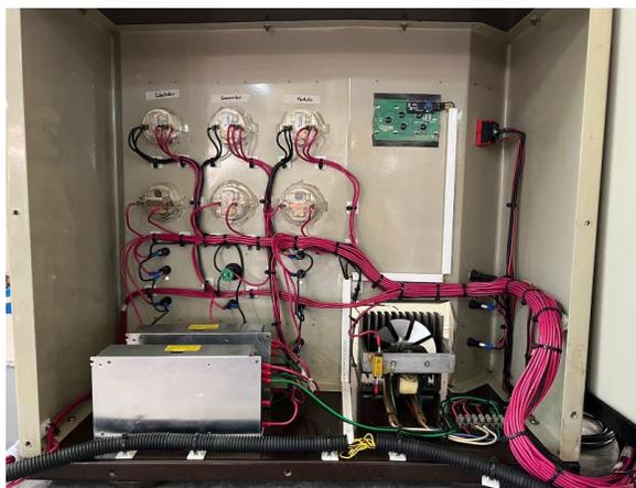
El equipo dispone de los siguientes actuadores para su funcionamiento. Un módulo Peltier instalado en el intercambiador de calor en la parte frontal del equipo, el mismo que se encuentra conectado mediante cables de calibre 16 AWG a los demás elementos del equipo. En la siguiente tabla se muestran los datos de dicho módulo
