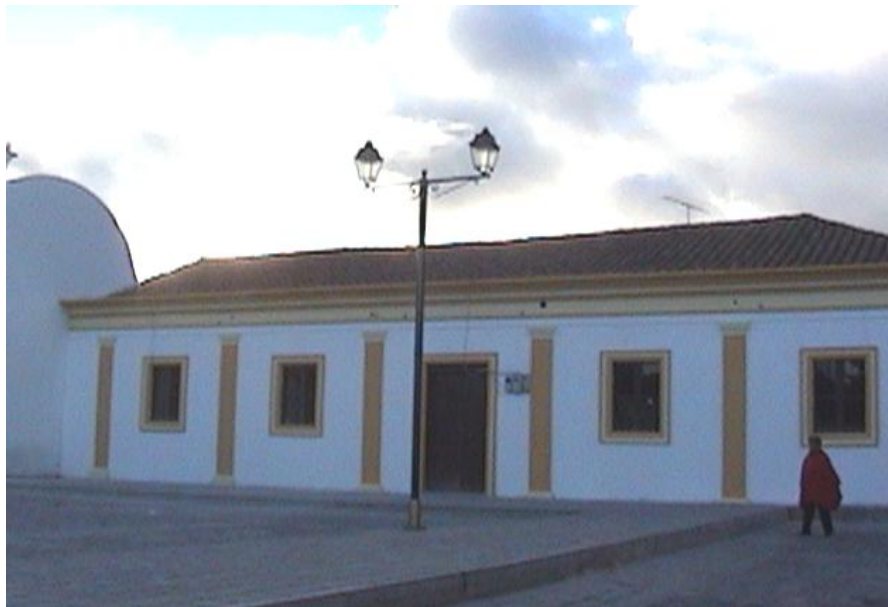
Oficinas de la Dirección de Agua Potable (Plaza de Santo Domingo)
