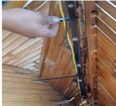
*Nota.* La figura representa la aplicación de placas de acero para sujeciones del bambú.
