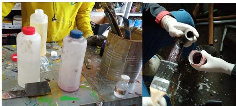
*Nota.* Componentes del aglutinante y la aplicación de fibra de vidrio a las uniones de perfilera y bambú.
