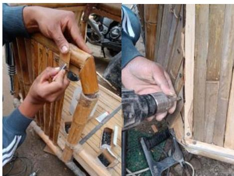
*Nota.* La figura nos muestra la sujeción del bambú a la estructura mediante auto perforantes y taladro.
