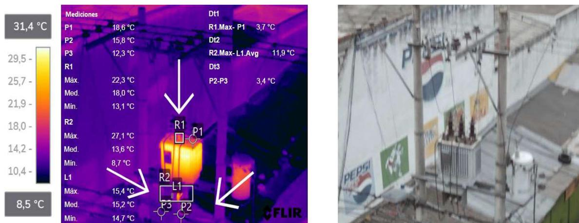
Este transformador se clasifica como fallo en MV, por jerarquía de nivel de criticidad, presenta un punto caliente en el Bushing de MV correspondiente a la Fase B con un  $\Delta T$  de 11,9 °C, y otros tres problemas en BV correspondientes al fusible NH, conector dentado y conductor de la Fase B.
