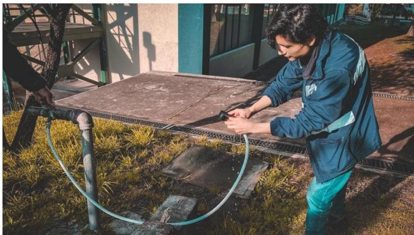
El segundo parámetro de medición fue en el inicio de la tubería interna del edificio administrativo con el uso de un caudalímetro IoT, en la plataforma se reflejan los datos de caudal cada minuto, los datos de medición se tiene desde agosto de 2021 hasta enero de 2023, los datos se depuraron de modo que se eliminen los datos atípicos del paquete para evitar desfases en los resultados. La medición del consumo de agua en el edificio administrativo se indica en la Figura 17.
