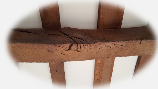
Estructuras de madera
