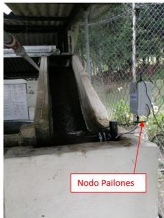
El lugar cuenta con un mallado de protección el cual nos sirvió de ayuda para poder colocar la caja del nodo a una altura de 1.20 metros, lejos del agua. También es importante mencionar que la caja que se uso tiene protección IP65 que sirve para exteriores, a su vez los conectores de los sensores y la antena se colocó cinta auto fundente para protección.
