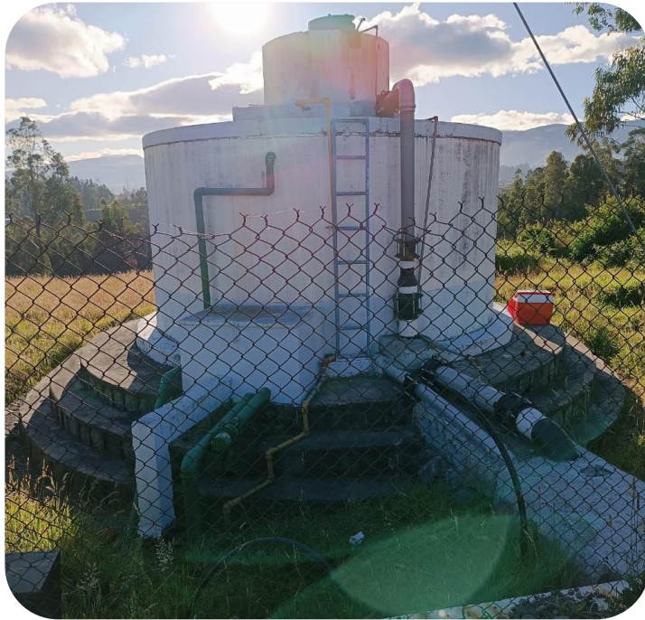
Tanque de almacenamiento Caudal actual: 8,5 L/s
