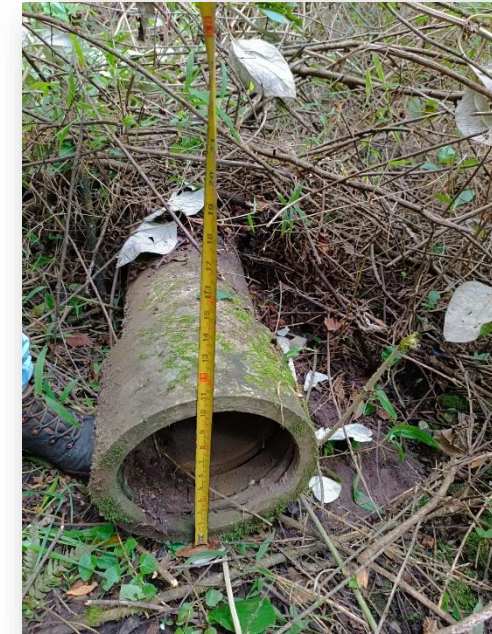
Material de la tubería
