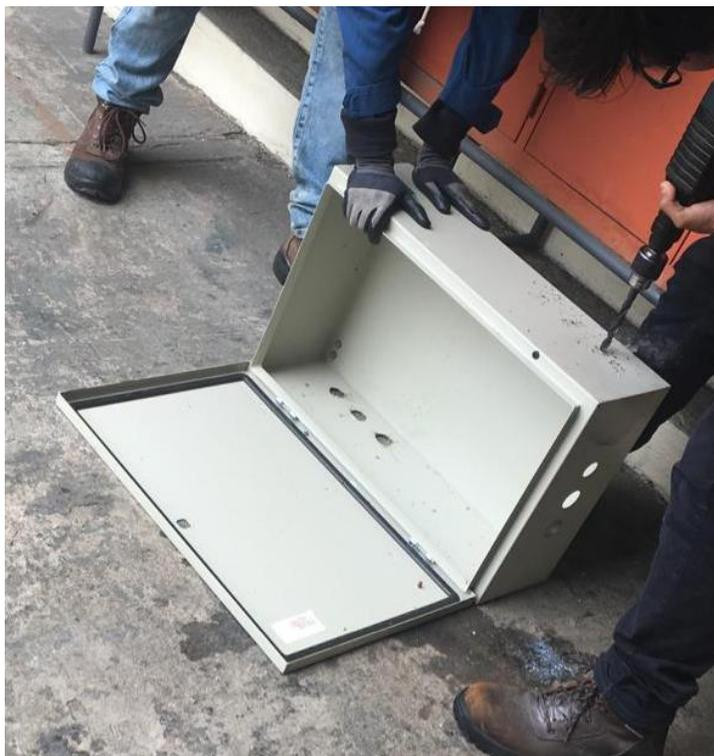
*Nota.* En la figura se muestra el proceso de perforado en el tablero de control.
